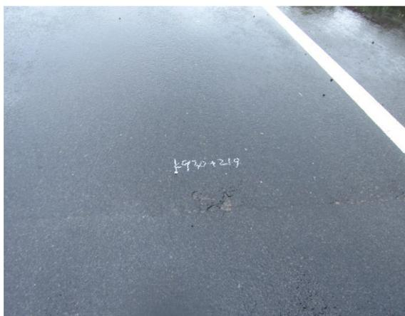
K930+219 施工横缝处坑槽
