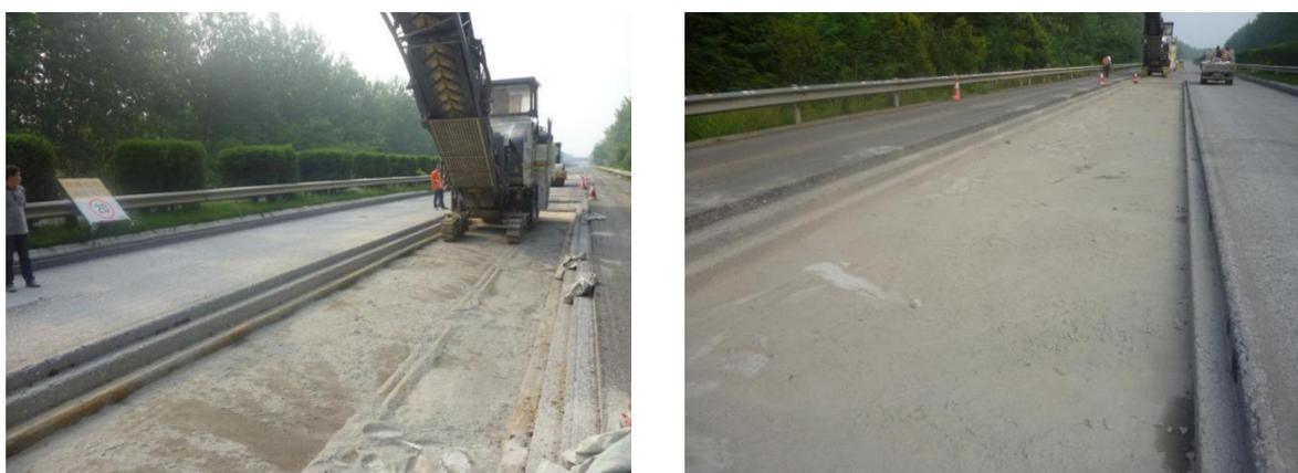
图 5-10 再生水泥土施工(撒布水泥)
