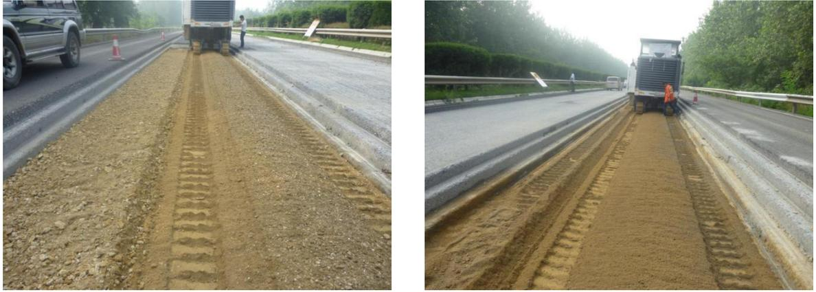
图 5-11 再生水泥土施工（就地拌和）
