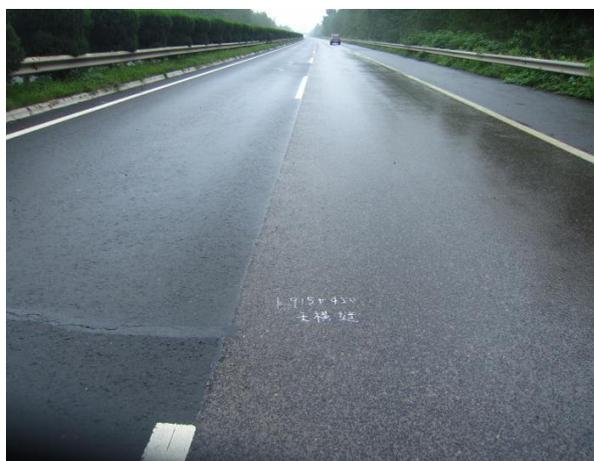
K915+450 行车道无裂缝
