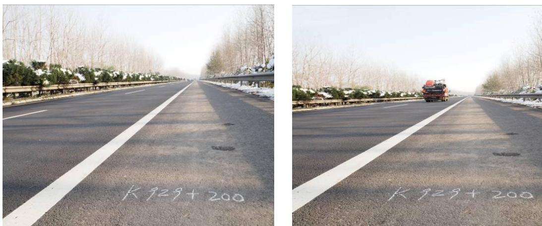
图 5-6 K929+200 冷再生路段路面坑槽
