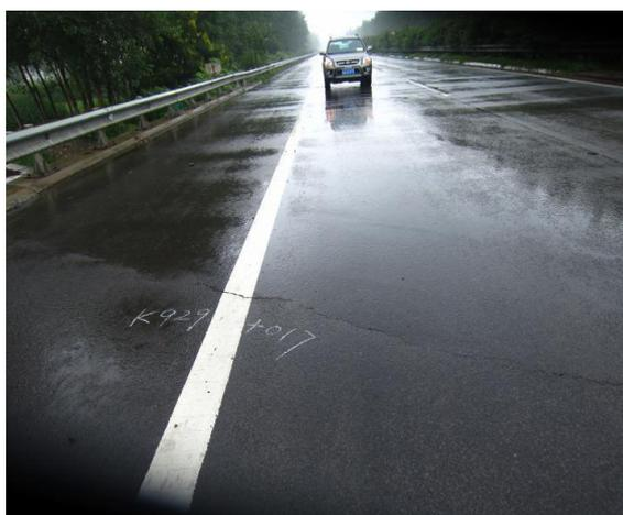
K929+017 桥头搭板处裂缝
