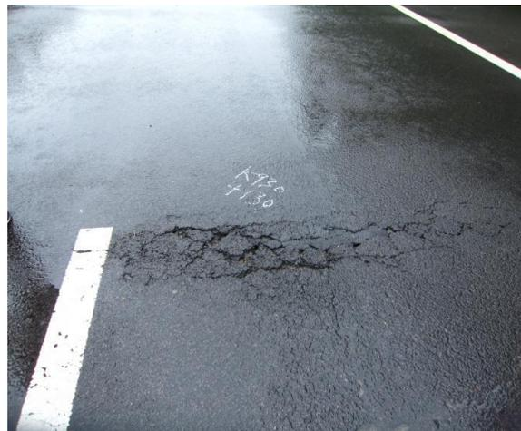
K930+130 桥头搭板处裂缝、松散
