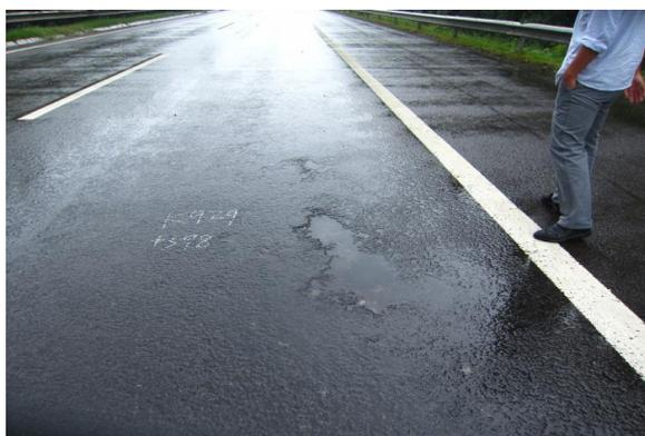
K929+598 行车道右侧轮迹带坑槽
