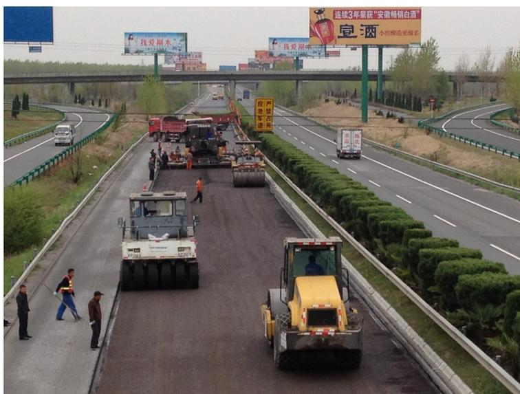
图 4-6 冷再生基层碾压施工
