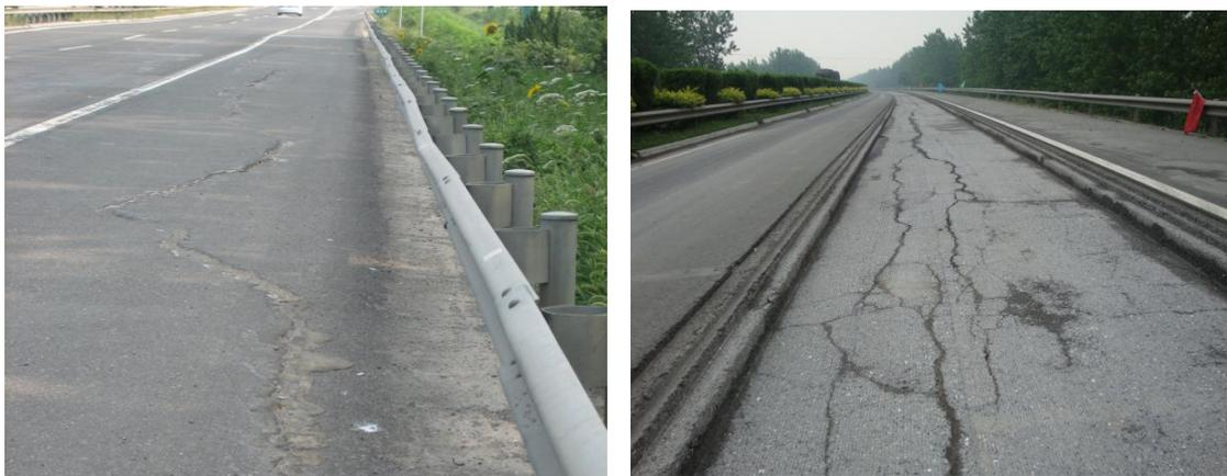
图 1-2 沥青面层及铣刨后水稳基层纵向裂缝
