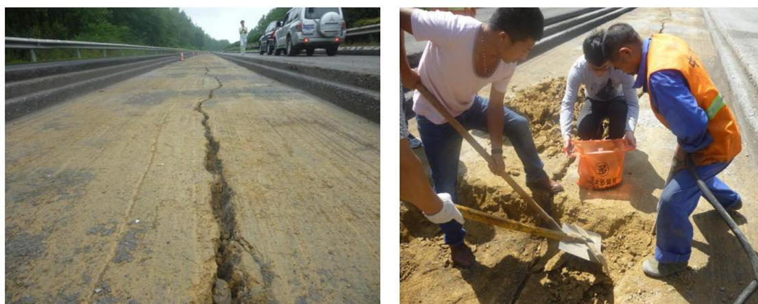
图 5-8 石灰土底基层、路基纵缝
