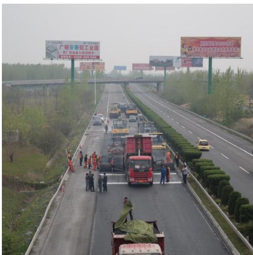
图 4-2 沥青中面层摊铺、碾压施工
