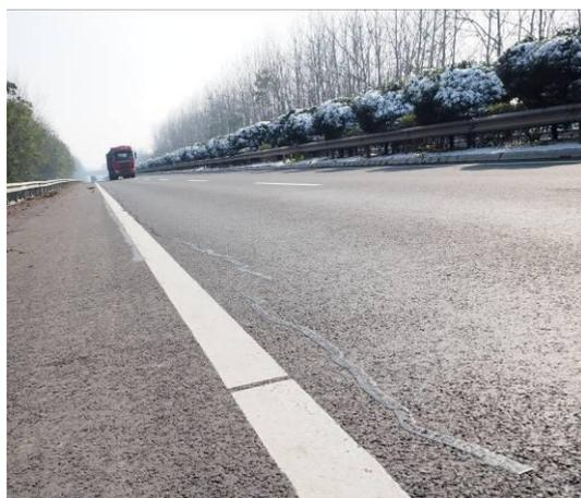
K992+000-K992+050 段纵向裂缝（施工缝附近）
