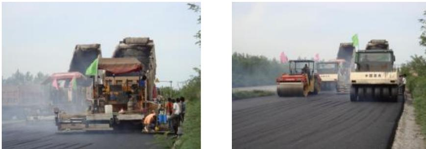
图 2.6 沥青路面摊铺及压实施工现场排放
