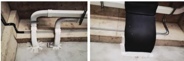
图 3 防水隔气膜现场施工图
