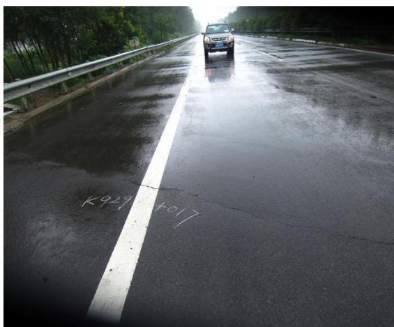
K929+017 桥头搭板处裂缝
