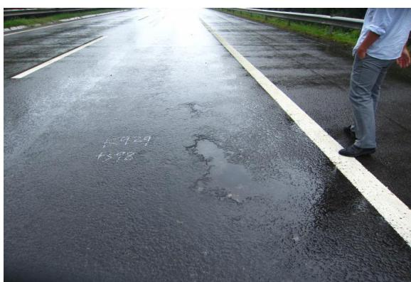
K929+598 行车道右侧轮迹带坑槽
