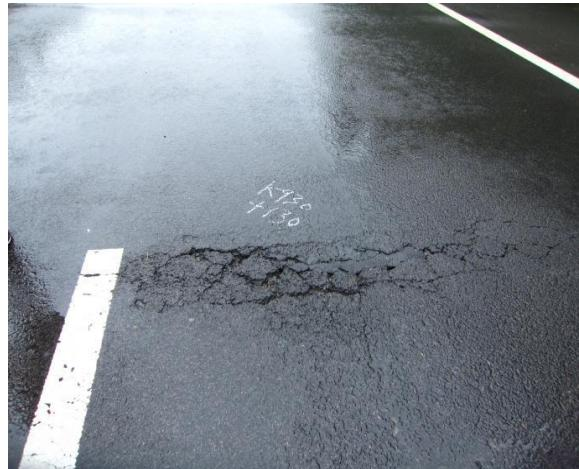
K930+130 桥头搭板处裂缝、松散
