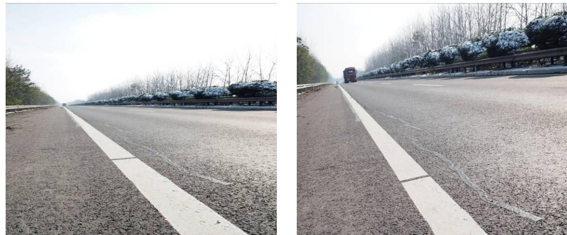
K992+000-K992+050 段纵向裂缝（施工缝附近）
