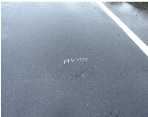
K930+219 施工横缝处坑槽
