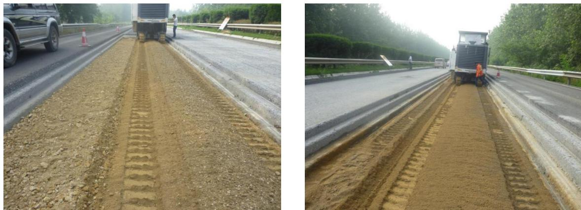
图 5-11 再生水泥土施工（就地拌和）
