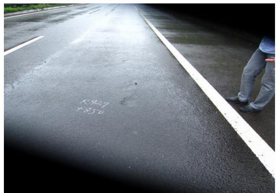
K929+850 行车道右侧轮迹带坑槽
