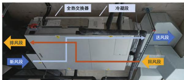
图 6 全热交换空调系统安装实景图
