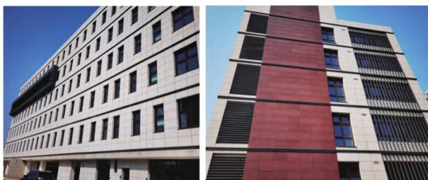
图 5 建筑自遮阳和建筑外遮阳布置图
